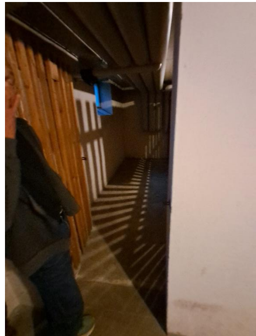
Kellerabteil mit eigener Beleuchtung und Steckdose
